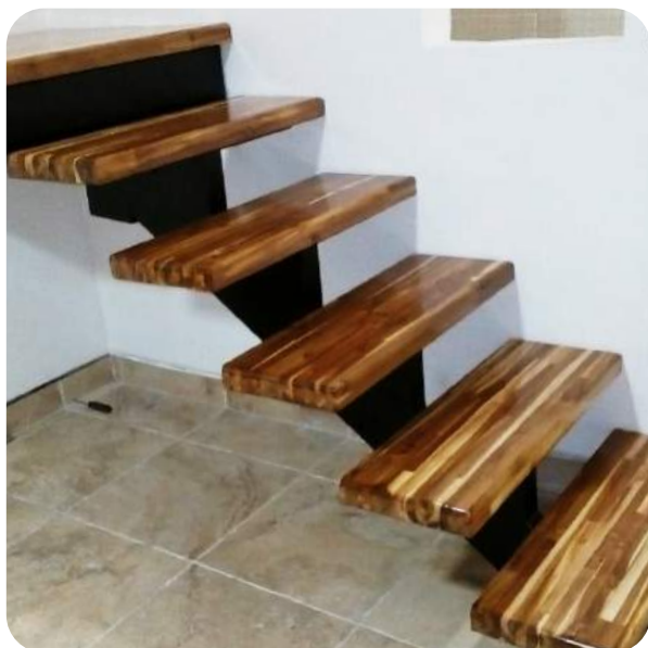
ESCALERAS FABRICADAS CON TABLERO "AL NATURAL" DE 4 cm DE ESPESOR
